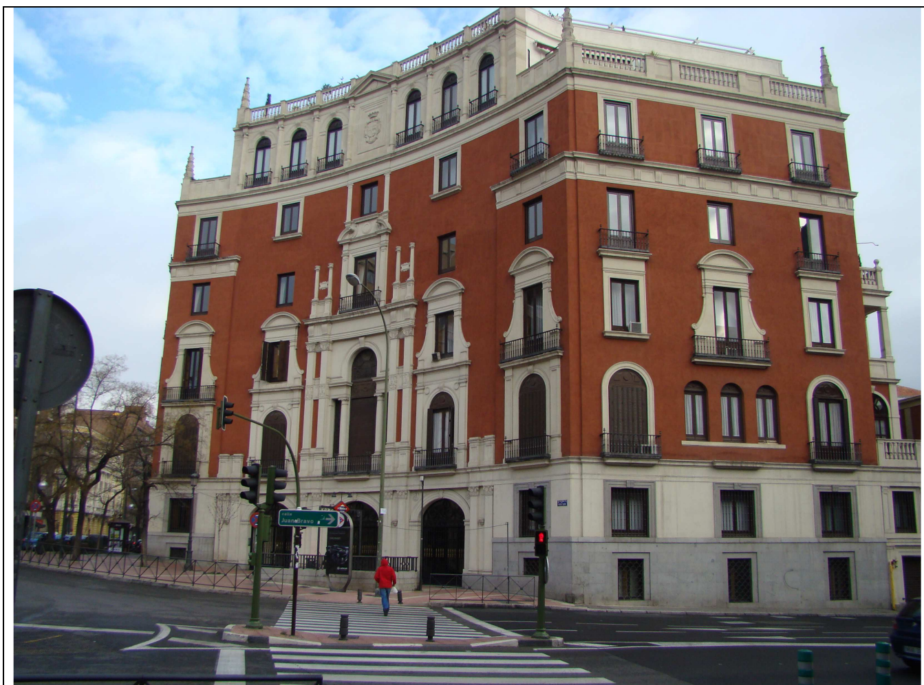
Edificio del Marqués de Ibarra en la glorieta de Rubén Darío (1929-1931)
